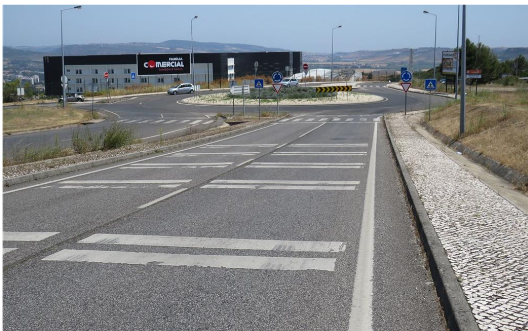
Figura 4.25 – Vista da estrada EN250, para área de inserção do traçado em túnel (Cut & Cover), cerca do km 0+400
